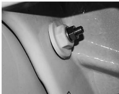
Рис. 2 – Закрепленная на стене раковина
